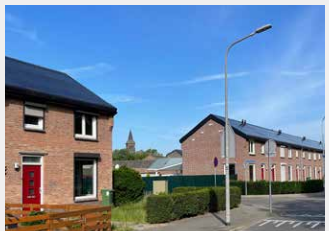
Geïntegreerde pv-panelen op zadeldaken
