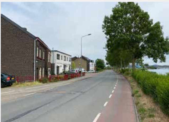
Bestaande situatie Borgharenweg ter hoogte van Beck in zuidelijke richting
