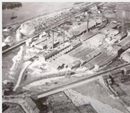
Zicht richting het noorden rond de jaren 50. Het noordelijke fabrieksterrein, de Maastrichtsche Zinkwit Maatschappij, sloot in 1950
