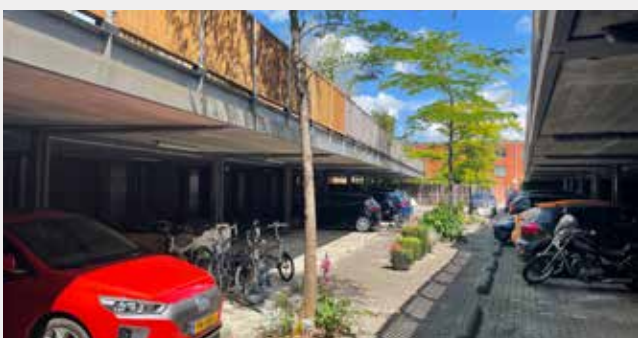
Een halfverdiepte gebouwde parkeeroplossing
