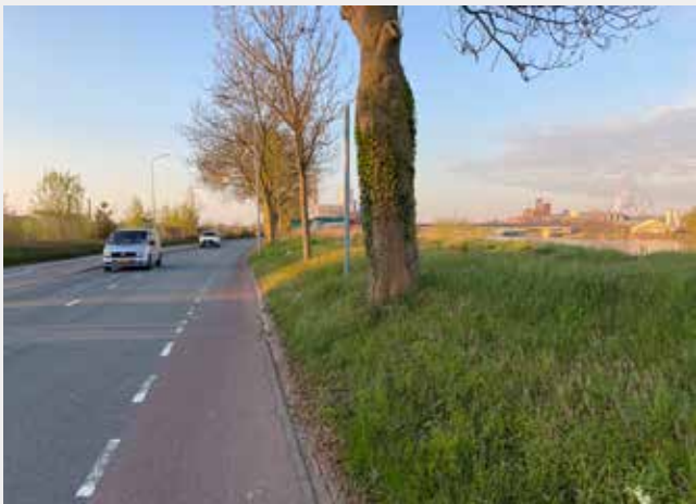
Bestaande situatie Borgharenweg in zuidelijke richting
