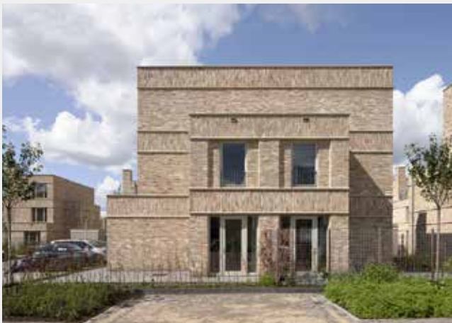
Strijp-R Eindhoven Architect: HCVA
