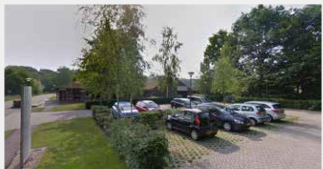
Parkeerplaatsen hebben open verharding, waardoor hemelwater kan infiltreren
